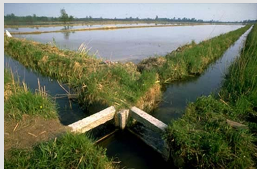
Figura 3 Fotografia 64 del PTPR Sistemi tradizionali di smistamento delle acque di irrigazione nella bassa pianura milanese. Comprendono le canalette che capillarmente portano acqua alle singole superfici coltivate; la rete irrigua lombarda ha uno sviluppo complessivo di 40.000 km
